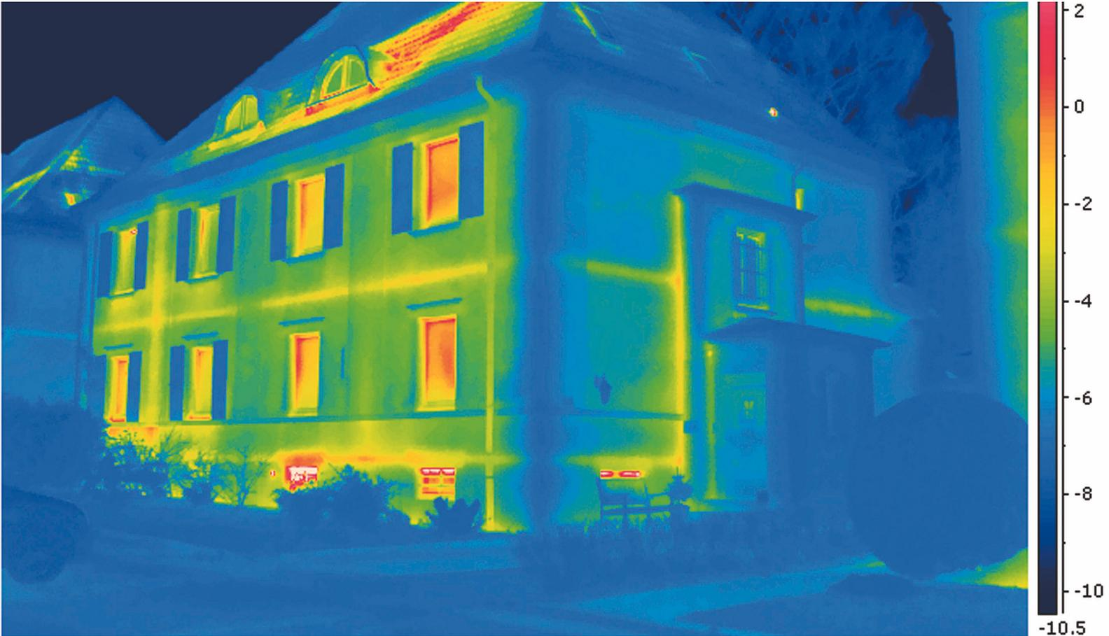
Von außen sind viele Häuser gleich. Durch eine Thermografie werden die Wärmeverluste sichtbar.
